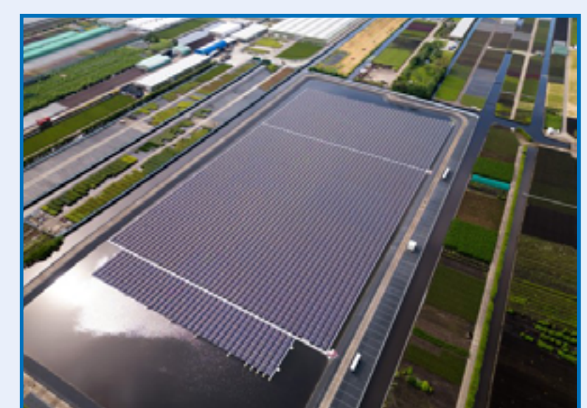
Aanleg waterberging met zonnepanelen dubbelfunctie
