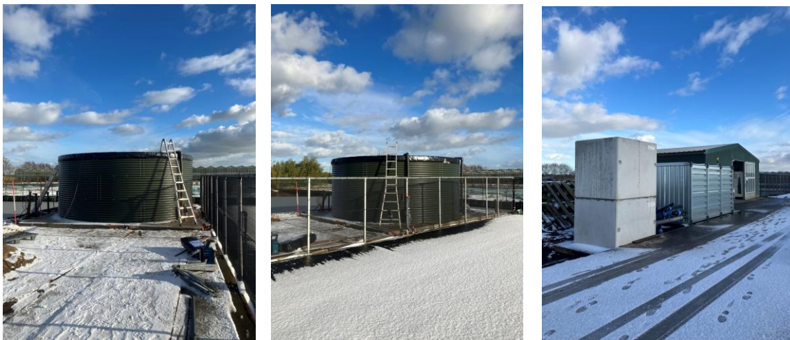
Figuur 4. Pilotinstallatie Van Lint met van links naar rechts: de SSF- silo + de betonnen pompput + de waterselectiecontainer naast het bestaande pomphuis
